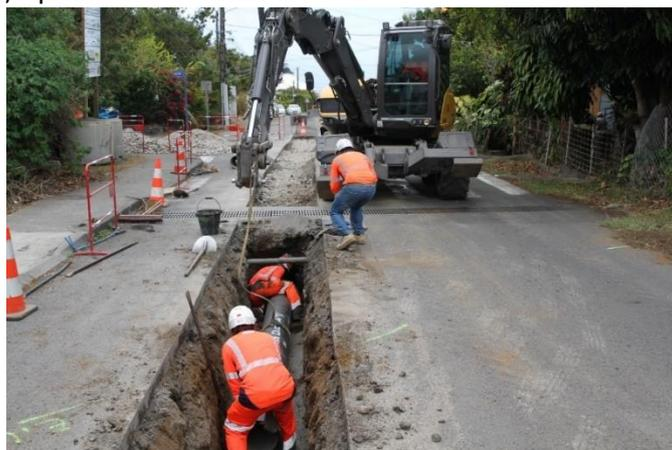
Figure 18 Exemple de pose d'une conduite sur la commune du Tampon : Au-delà de la lutte contre les fuites, des bonnes conditions de pose des réseaux permettent d'assurer leur pérennité
