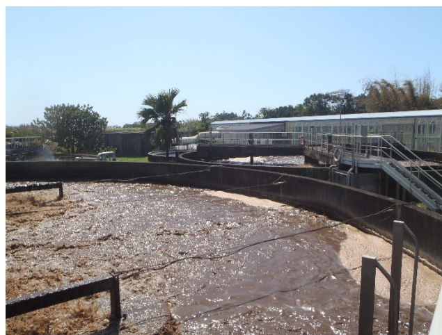
Vue sur les deux bassins d'aération de la STEU de Bras Panon
