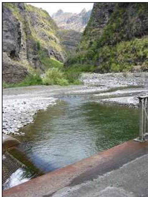
Rivière des Galets au captage (sortie de galerie Mon Repos)
